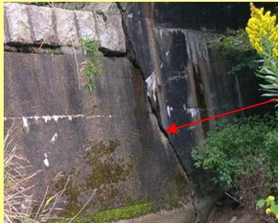
砂防堰堤に大きな亀裂が発生
