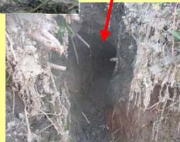
堤防除草を定期的に行わないとミミズが生息するようになります。それをエサとするモグラなどにより堤防に穴があき、堤防の強度が低下します。
