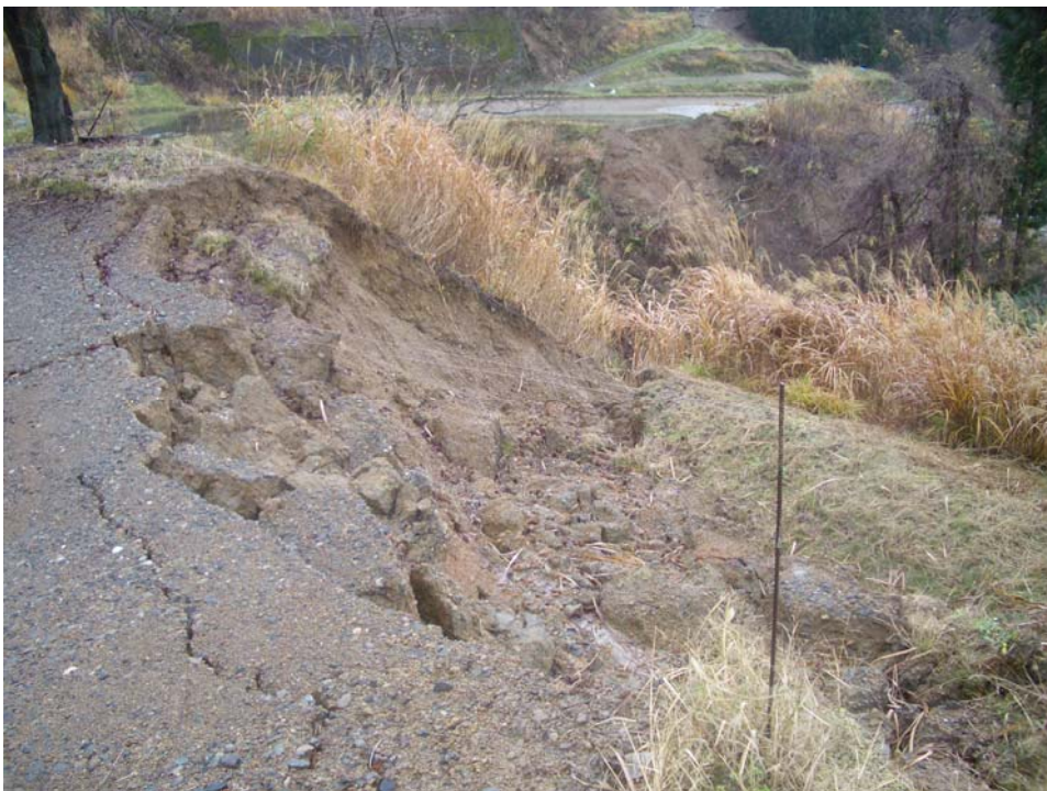
崩れた養鯉場の縁、上の写真の右上部分 撮影：初村 尤而、2004年12月8日
